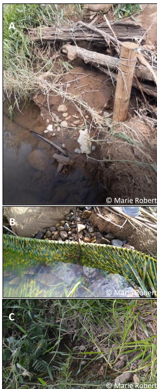
Figure 13 Point d'érosion à l'amont de la berge (A), recharge en galets et protection en tressage de feuille de coco à 3 mois (B) et à 7 mois (C).
