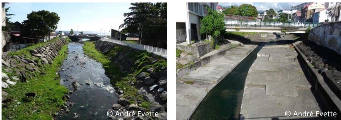
Figure 1 Exemples d'aménagements en génie civil de berges de cours d'eau en Guadeloupe.
