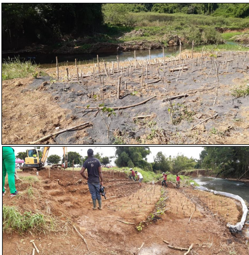
Figure 10 Photographies de l'ouvrage lors de sa mise en place en novembre
