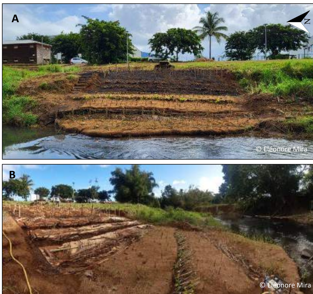
Figure 9 Photographie du chantier, vu de face (A) et profil (B) lors de sa mise en place en novembre 2022.
