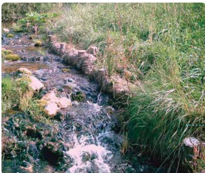
**LA FASCINE D'HÉLOPHYTES\*** est un ouvrage de protection et végétalisation de pied de berge, réalisée via la confection d'un "boudin" en géotextile biodégradable, rempli de terre et de plants d'hélophytes, et maintenu au sol par une rangée de pieux morts. ....
