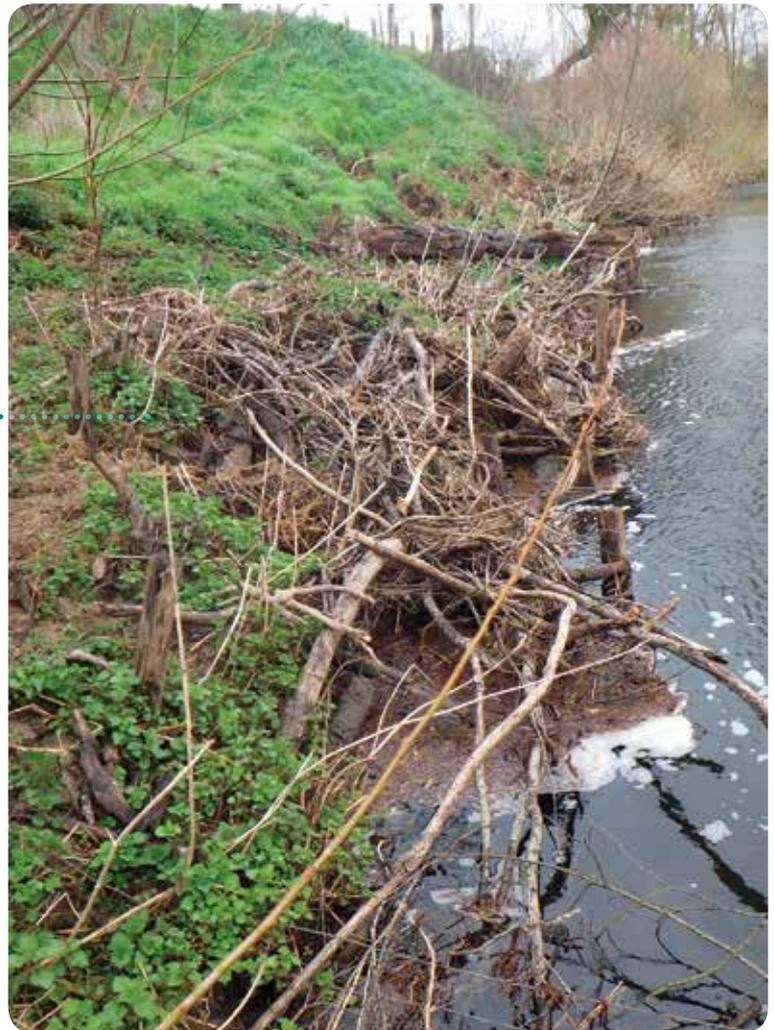
**LE TREILLAGE BOIS** est une structure superficielle en rondin faite pour retenir le sol sur les fortes pentes.
