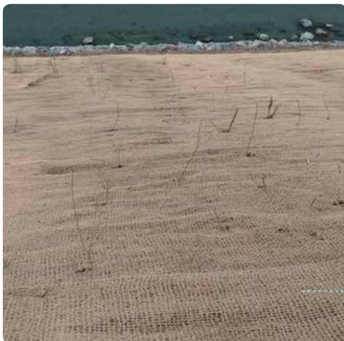
**LES GÉOTEXTILES BIODÉGRADABLES** sont des nattes constituées de fibres naturelles. Ils ont pour principales fonctions d'éviter les risques d'érosion superficielle des sols avant la reprise des végétaux implantés et de protéger les graines du ruissellement. Il existe des géotextiles aux caractéristiques techniques très différentes (matière, tissage, grammage etc.) qu'on utilisera différemment en fonction des contraintes du milieu et des résultats attendus. ....
